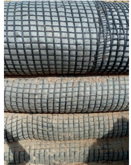
Abb. 4: Links: Herstellung des geogitterbewehrten Gründungskörpers mit Stützschalung; rechts: Kontrolle der Formstabilität Fotos: Autoren
