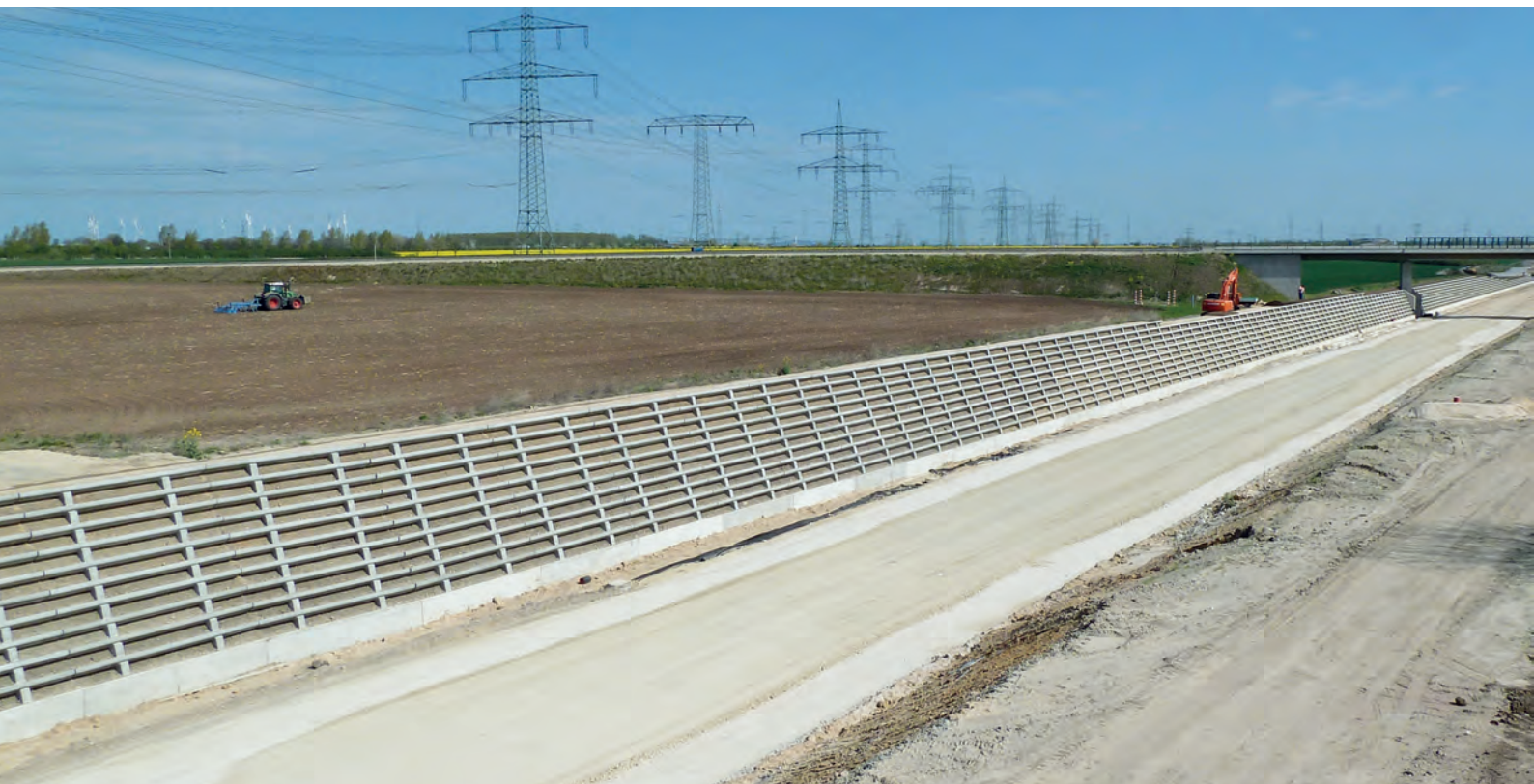
Abb. 1: Fertiggestellter Wandabschnitt bei NBS-km 268,200 im April 2012
