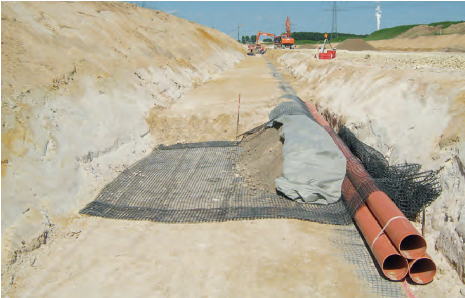
Abb. 4: Links: Herstellung des geogitterbewehrten Gründungskörpers mit Stützschalung; rechts: Kontrolle der Formstabilität Fotos: Autoren
